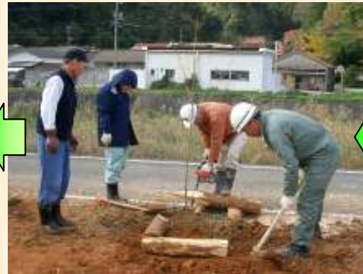
▲桜の根元の土が崩れないように、余った間伐材でツリーサークルをつくります
