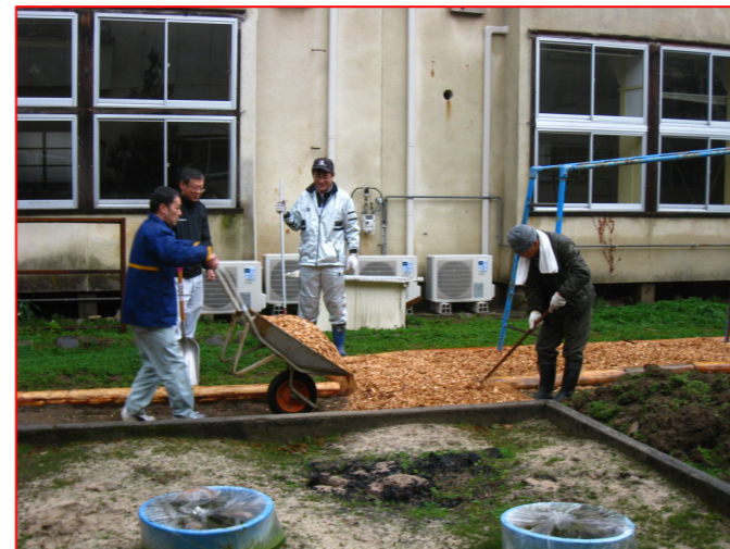
▲ウッドチップを中庭に敷き均します
