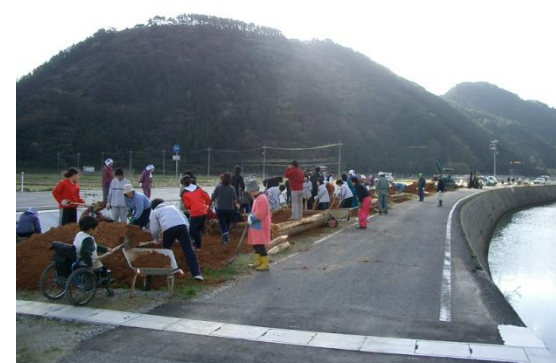
住民施工実施（県道の残地の活用）
