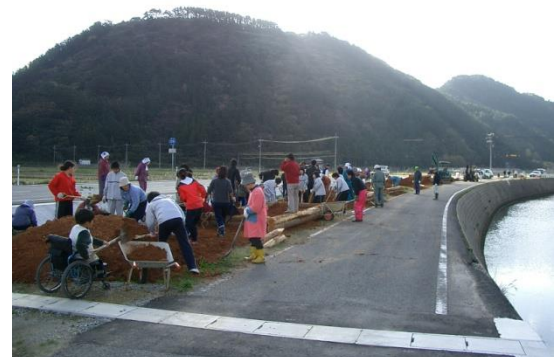
住民施工実施（県道の残地の活用）
