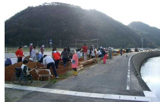
住民施工実施（県道の残地の活用）
