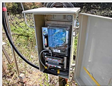
センサユニット実装・設置状況
